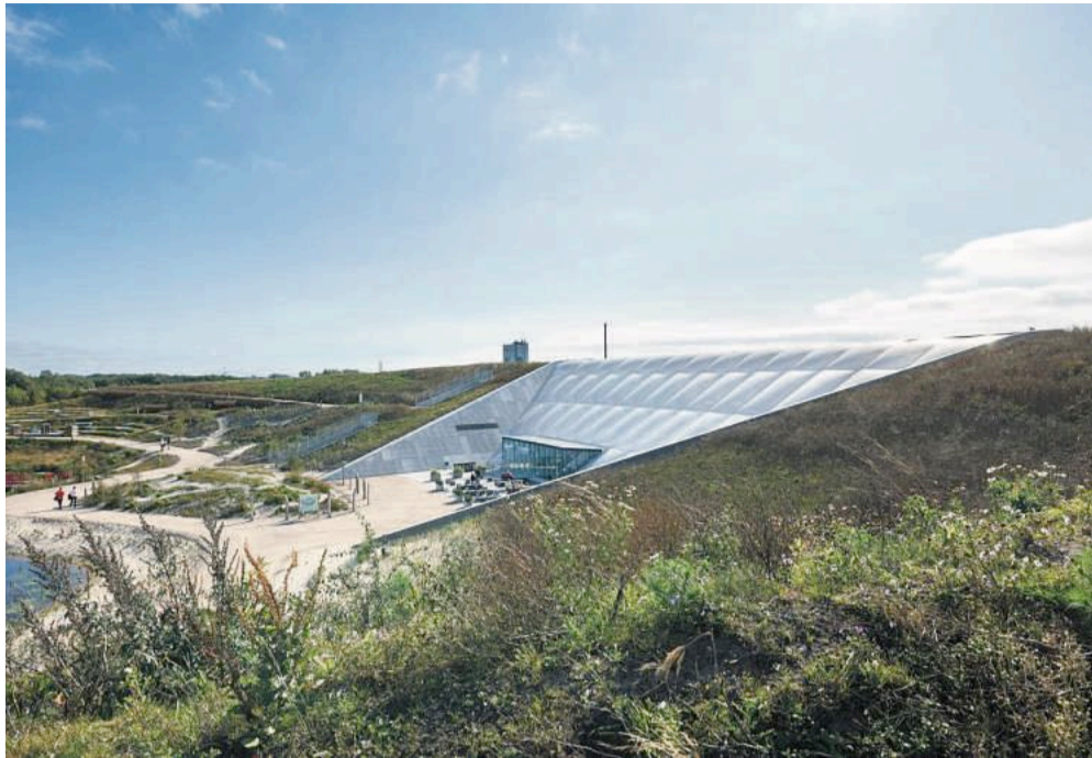
Den del af Naturkraft, der foregår indendørs, er bygget ind i skrænten. Foto: Torben Petersen/Naturkraft
