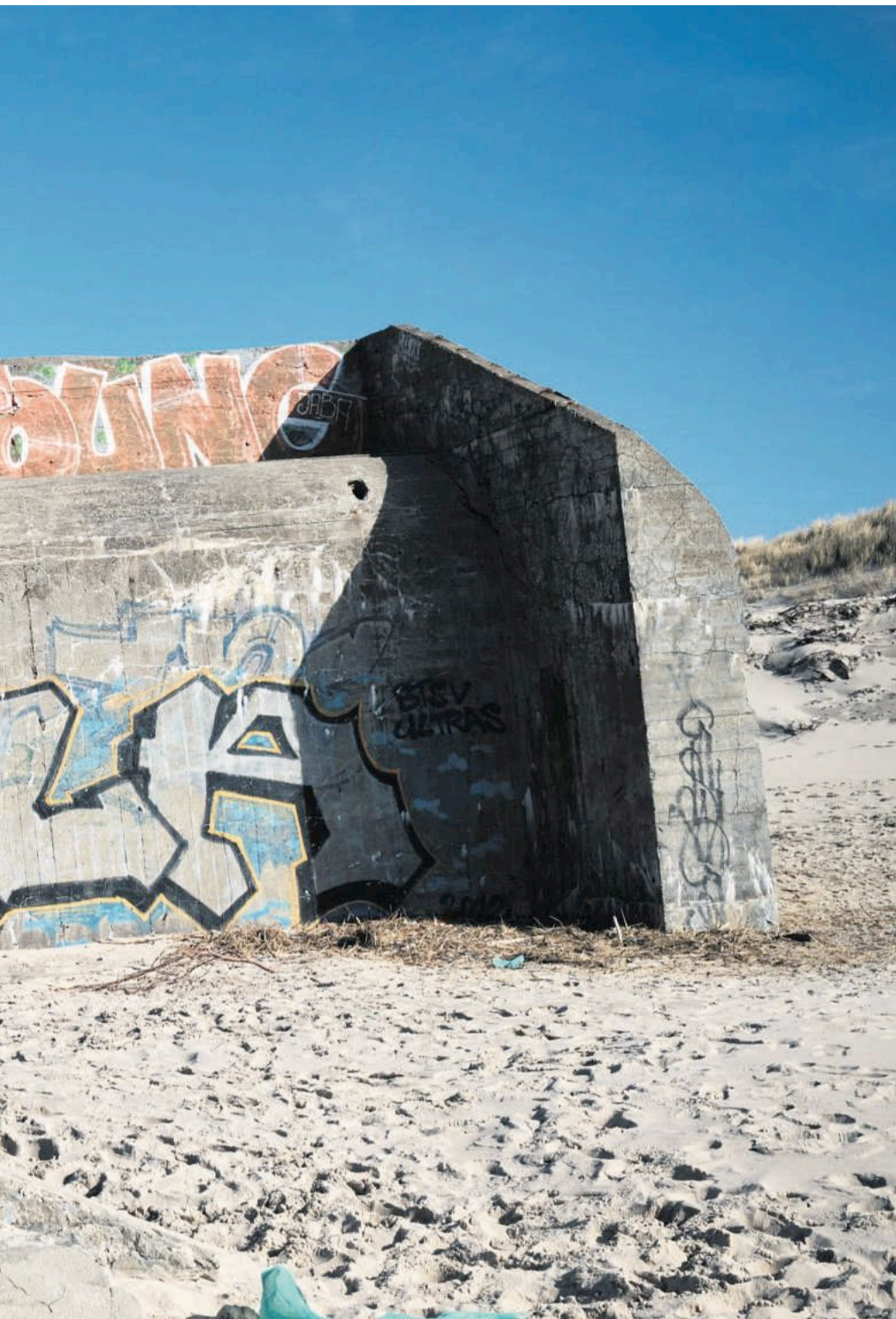
Houvig Fæstning består af omkring 50 bunkere, hvoraf de største er på størrelse med parcelhusgrunde. Foto: Simon Staun
